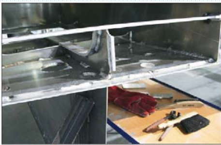
在安装他们到 Bestevaer 船体之前，复杂的加强型船体甲板 T 部位需要进行组装。
